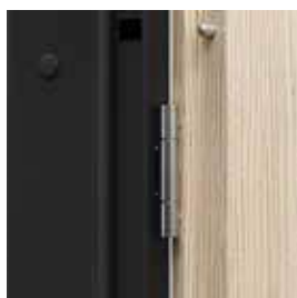
trei balamale din 3 elemente
